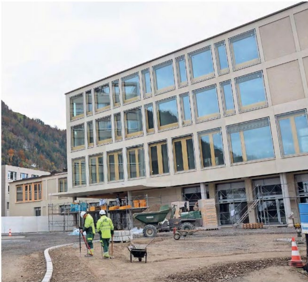
Aussen sind die Arbeiten am neuen Kantonsspital schon fast abgeschlossen. Im nächsten Frühling soll dann auch der Innenbereich fertiggestellt sein. FOTO: SIMON GISLER
