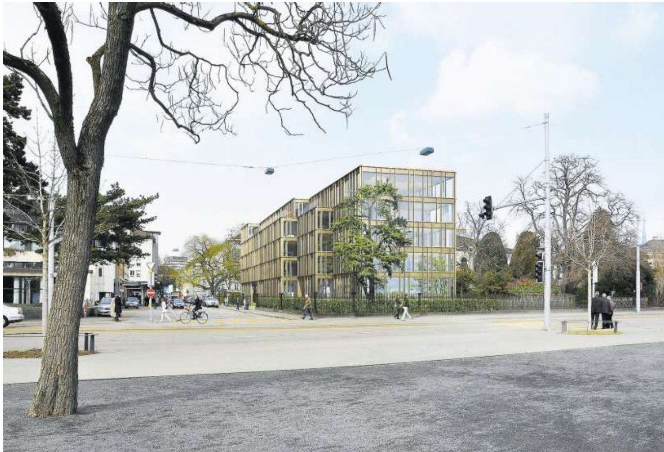
An bester Lage neben Kongresshaus und Tonhalle entsteht derzeit ein bronzefarbener Blickfang.
