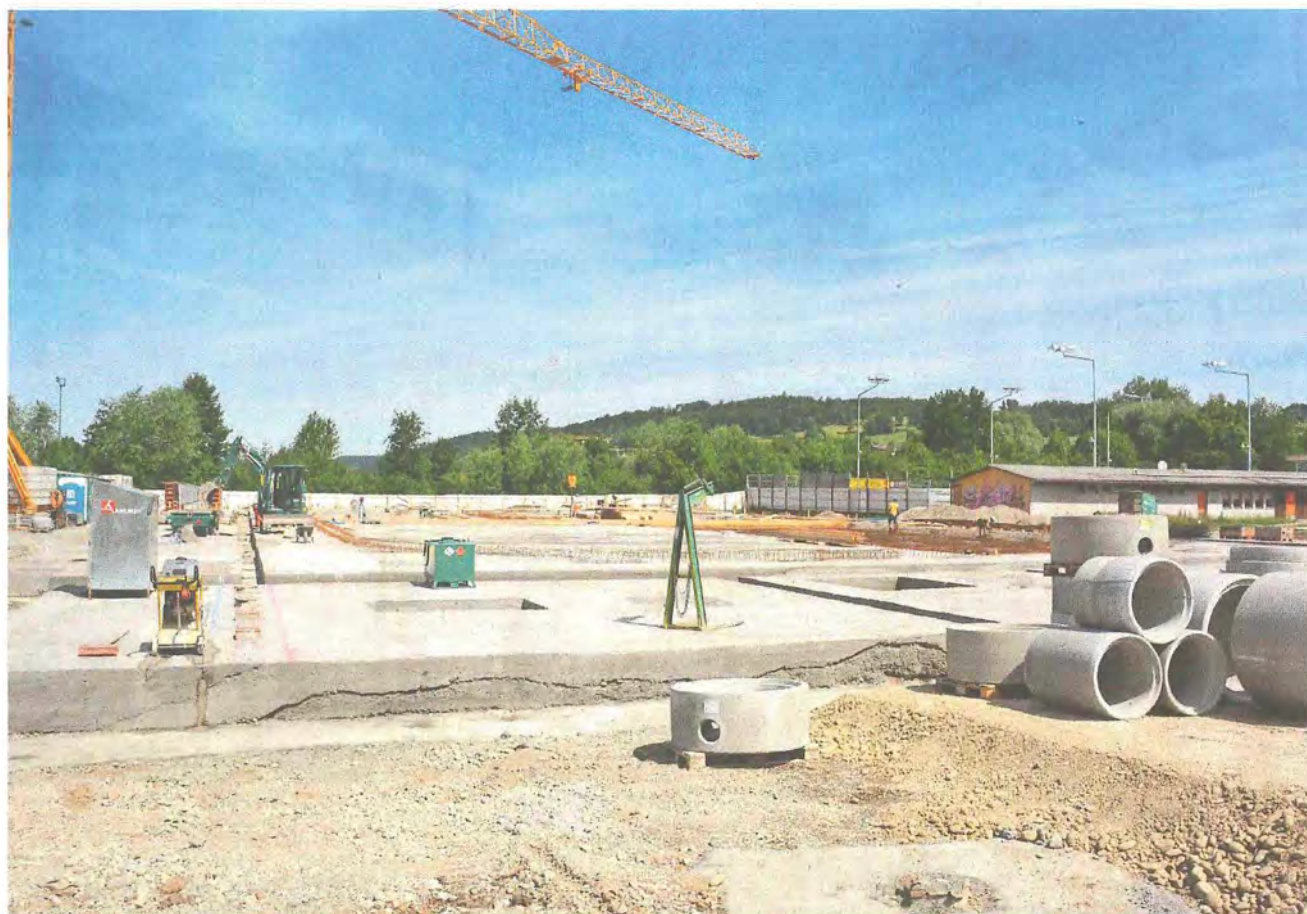
Die Arbeiten für die Betonplatten kommen gut voran. Schon bald kann mit dem Hochbau begonnen werden. Trotz der Grösse des Geländes kommt dafür nur ein Kran zum Einsatz.
