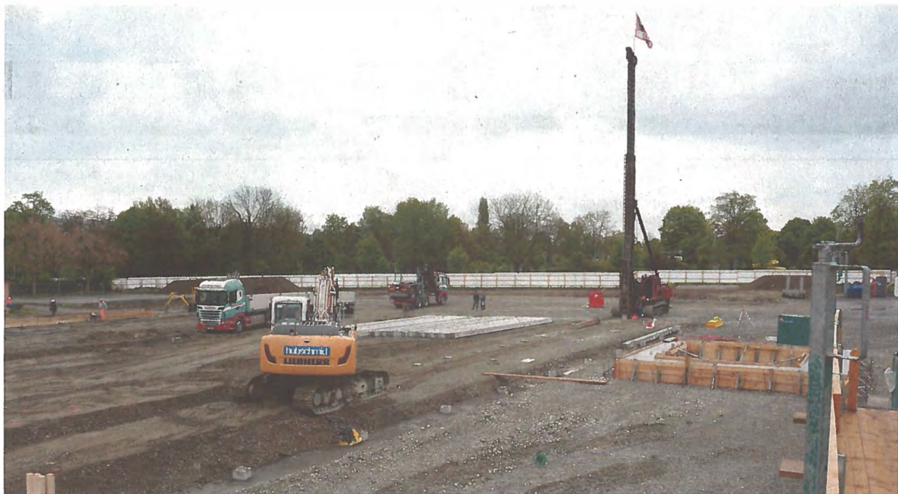
Noch ist nichts zu sehen von der künftigen Eishalle: Die jetzigen Arbeiten dienen nur zur Vorbereitung des Untergrundes für die späteren Hochbauten.
