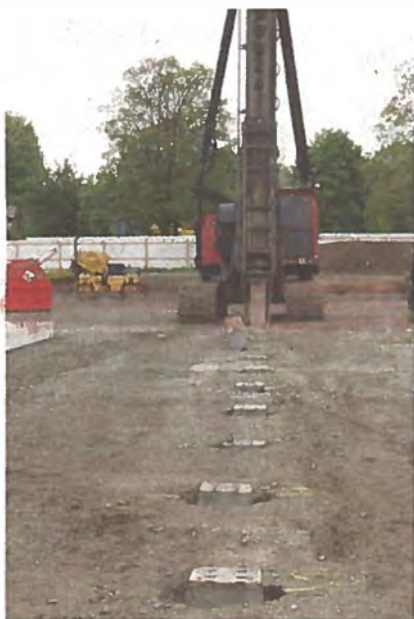
Die Pfähle werden in regelmässigen Abständen in den Boden gerammt.
