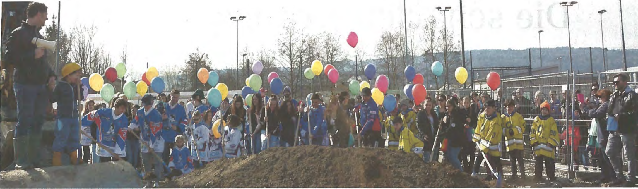
Der offizielle Baustart zum Grossprojekt: Die Nachwuchskräfte der Vereine legten sich mächtig ins Zeug – und machten den Spatenstich zum stimmungsvollen Ereignis.
