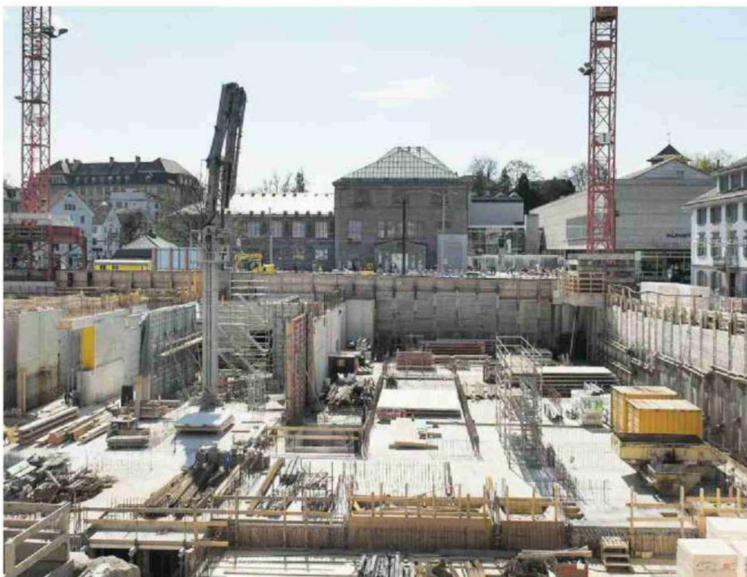
Blick in die Baugrube des Erweiterungsbaus des Zürcher Kunsthouses.
