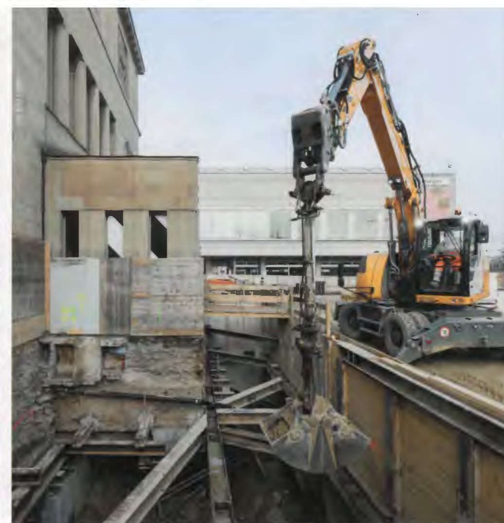
Der 1910 erstellte Moser-Bau wurde bei laufendem Betrieb unterfangen, um ein zusätzliches zweites Kellergeschoss zu bauen. Der ehemalige Haupteingang des Kunsthauses ist derzeit geschlossen.
