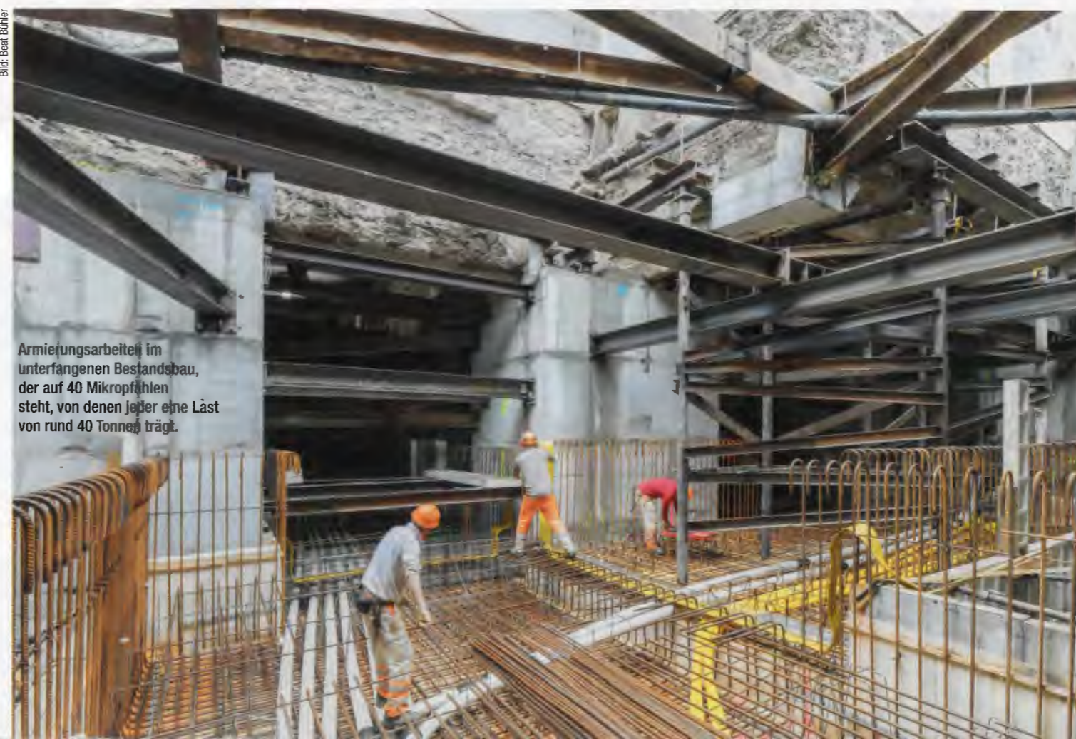
Der 1910 erstellte Moser-Bau wurde bei laufendem Betrieb unterfangen, um ein zusätzliches zweites Kellergeschoss zu bauen. Der ehemalige Haupteingang des Kunsthauses ist derzeit geschlossen.
