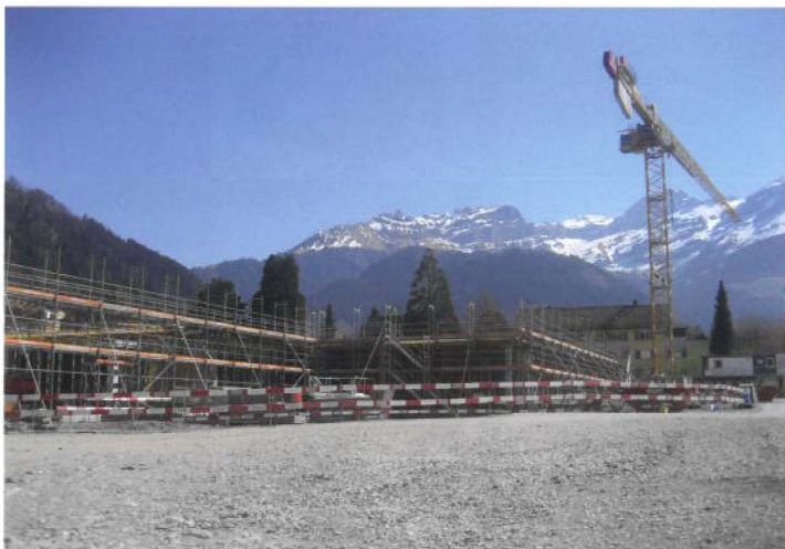
Baustellenaufnahme vom 10. April 2020 (Renato Polentarutti).
