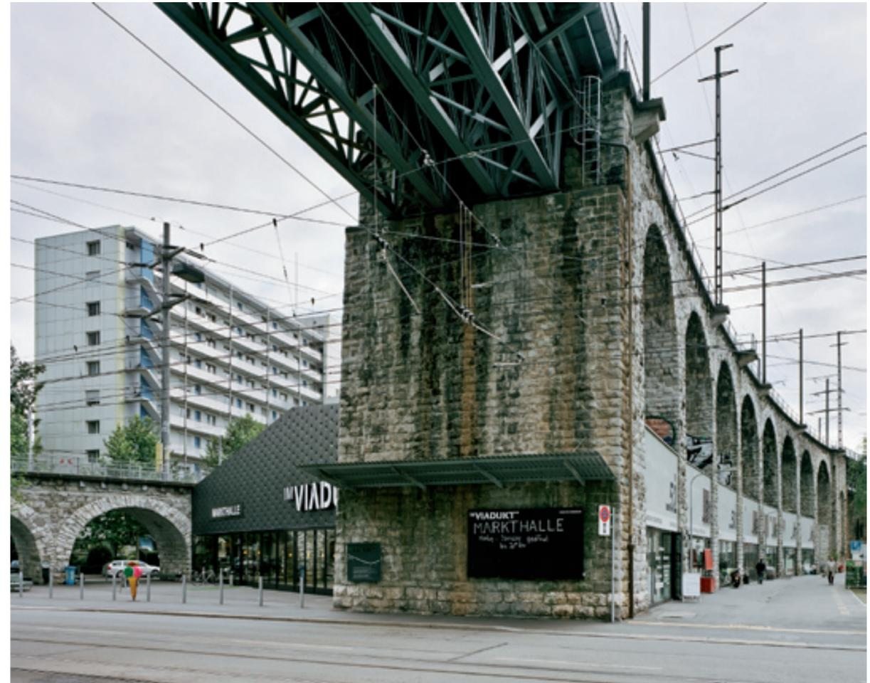
zwischen dem geraden Stück der Brückenpfeiler unterstreichen die Länge des Bauwerks. Durch diese niedrigen Neubauten bleiben die Brückenbögen sichtbar und präsent. Das über hundertjährige Zyklopenmauerwerk der Viaduktbögen wurde sorgfältig restauriert, das Mauerwerk ist auch nach der Umnutzung unverbaut. Von aussen prägen so die unregelmässigen, sorgfältig geschichteten Steine weiterhin den Charakter des Viadukts.
