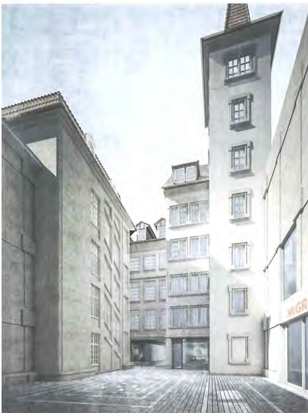
Migros an der Berner Marktgasse: Hier entsteht ein «historischer» Hof.
