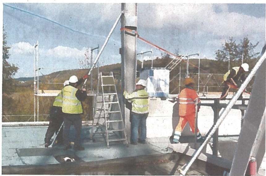
Für den Einbau der Beleuchtung ist die Firma Hevron als Leader auf dem Stahlbaumarkt.
