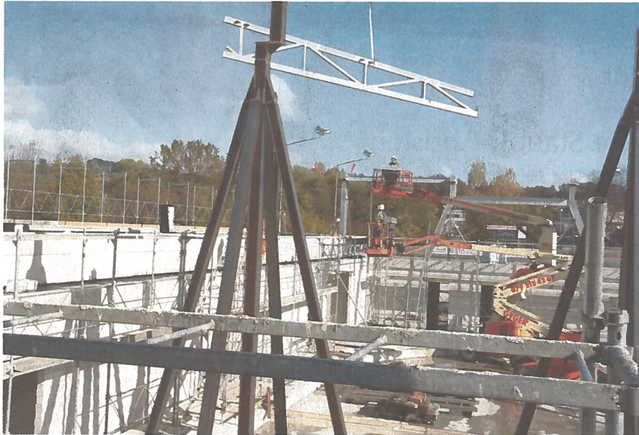
Der grosse Moment: Der allererste Stahlträger für das Dach wird an seinen Platz gehievt. Für die Montage wurden mehrere Hilfsgerüste aufgebaut.
