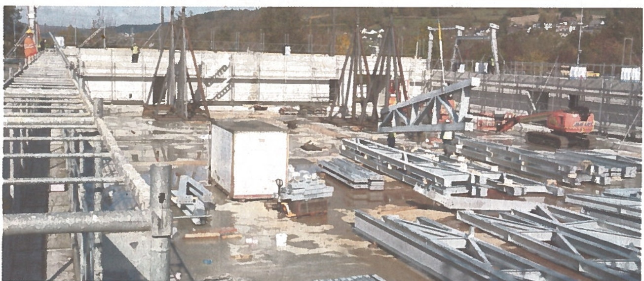
Auf dem künftigen Eisfeld werden die Stahlträger zwischengelagert, die Baumeisterarbeiten sind fast abgeschlossen.
