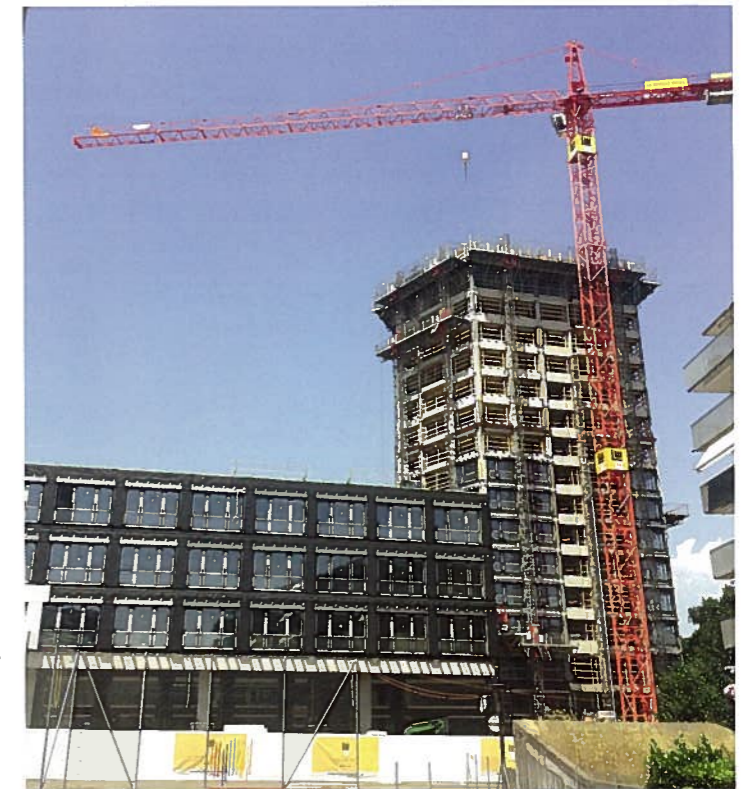
Der Tower im Bau
