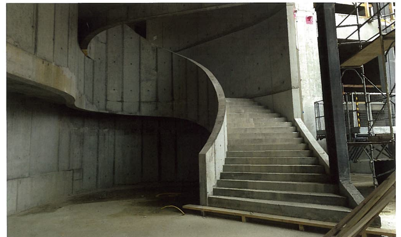
Das modern gestaltete Treppenhaus
