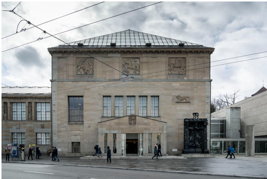
Das Hauptgebäude des Kunsthauses, erbaut 1919 nach Plänen von Karl Moser. Foto: Andrea Zahler/Tamedia AG
