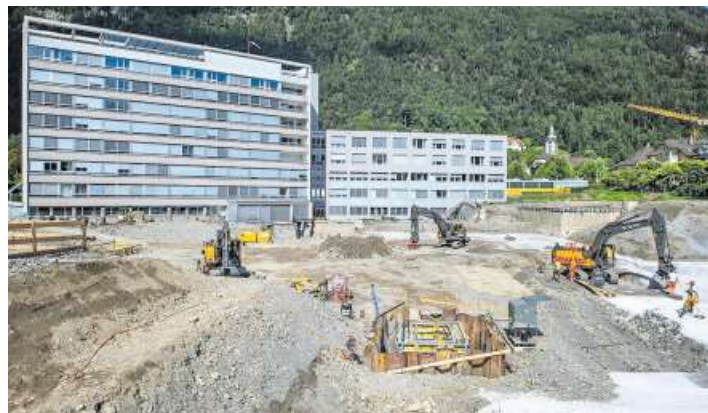
Im Mai dieses Jahres wurde mit den umfangreichen Aushubarbeiten begonnen. Bild: Baudirektion Uri
