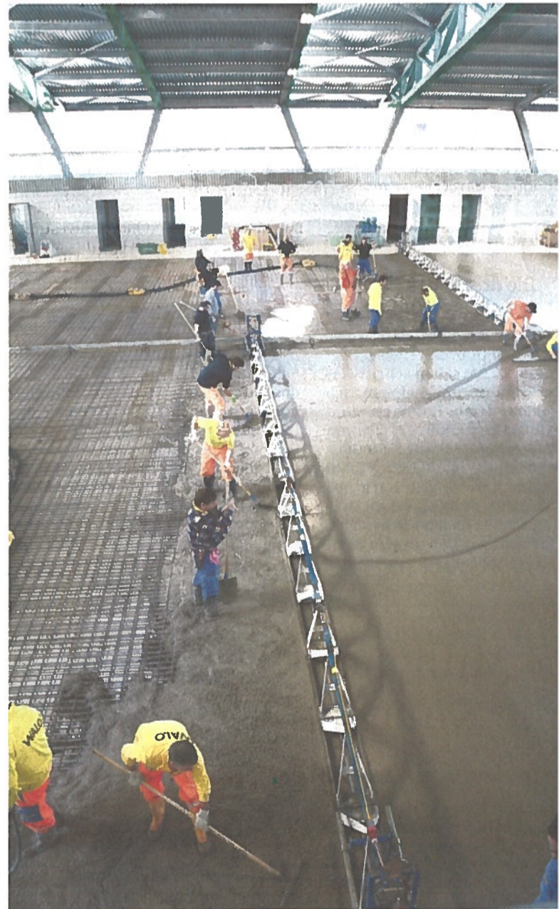
Arbeiten im Takt. Erst wird der Beton eingebracht, dann verteilt und schliesslich zweiseitig angebrachten Anlage abgestrichen. Dabei ist viel Muskelkraft gefragt.
