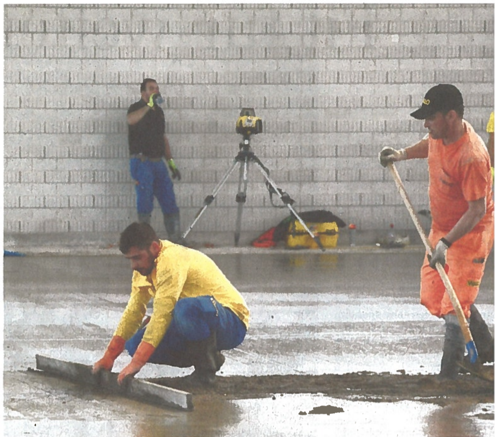
Zwei grosse automatische Anlagen strichen den Beton jeweils auf ihrer Seite ab. In der Mitte allerdings war dann Handarbeit nötig.
