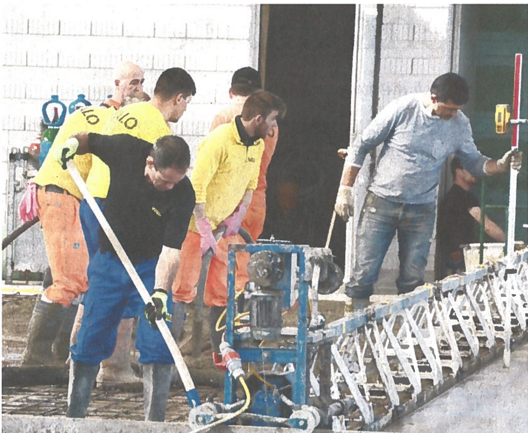
Immer wird nachgemessen, ob die Höhe stimmt: Kleinste Abweichungen können später grosse Auswirkungen auf die Qualität des Eises haben.
