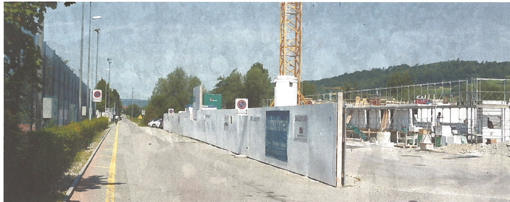
Sensible Zone: Vor der Eishalle (rechts) soll ein attraktiver Vorplatz entstehen und die Erschliessung wird über den Sorenbühlweg erfolgen, dieser soll um 1,5 Meter verbreitert werden. Links die Tennisanlage.
