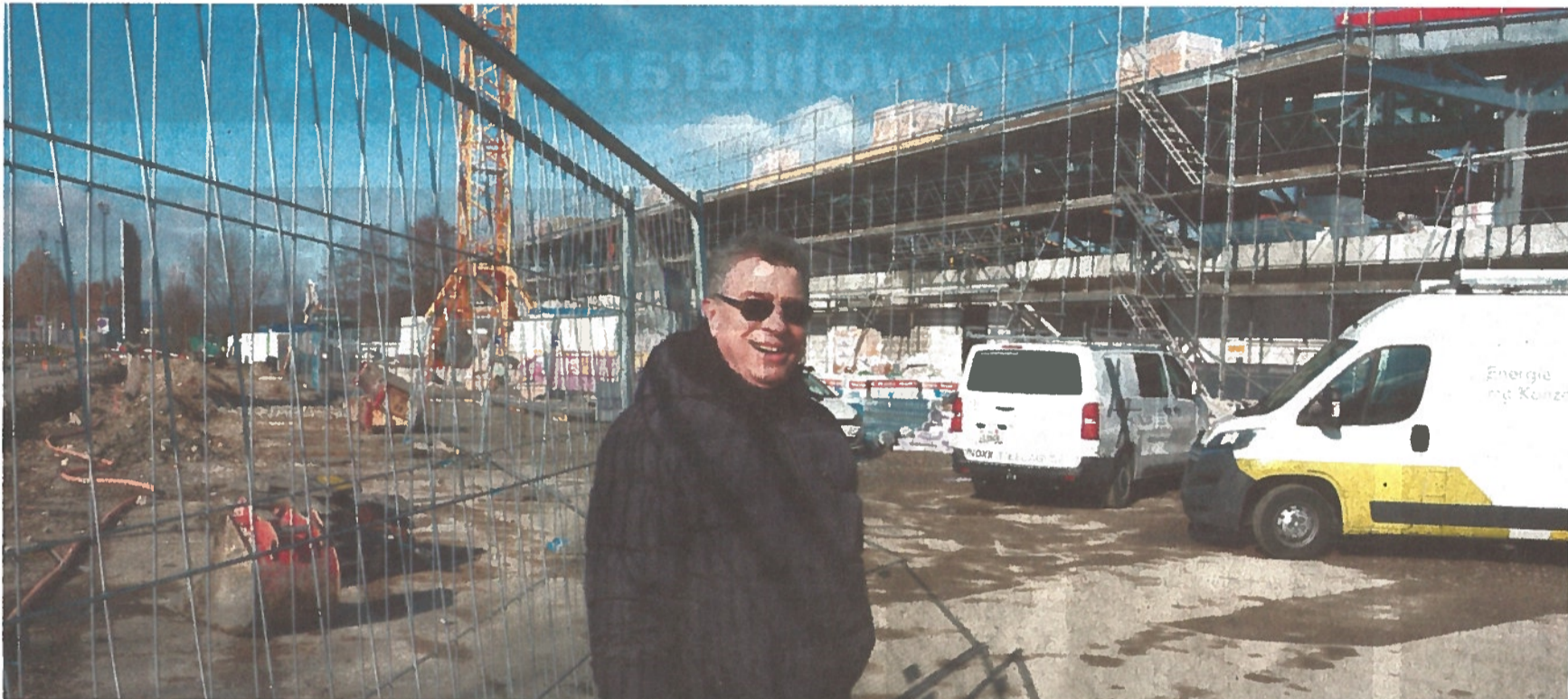
Gemeinderat Paul Huwiler freut sich, der Bevölkerung die Baufortschritte zu zeigen. Am 23. Februar findet das Rohbaufest statt, einen Tag später darf die Bevölkerung die Baustelle besichtigen. Bild: Chregi Hansen
