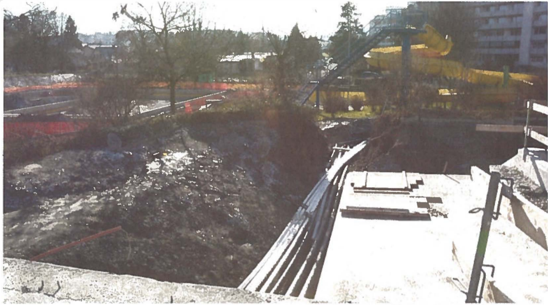
Baustelle statt Freizeitspass: In der Badi laufen die Arbeiten auf Hochtouren. Schlecht sieht es für die grosse Rutschbahn aus – eine Sanierung lohnt sich nicht, jetzt wird ein Ersatz angestrebt.
