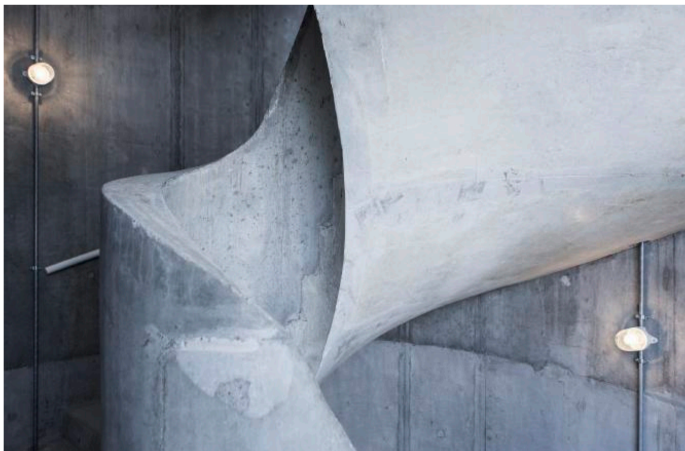
Im Innern eines Treppenturms sind die Arbeitsspuren im Beton gut sichtbar. Fotos: Giorgia Müller
