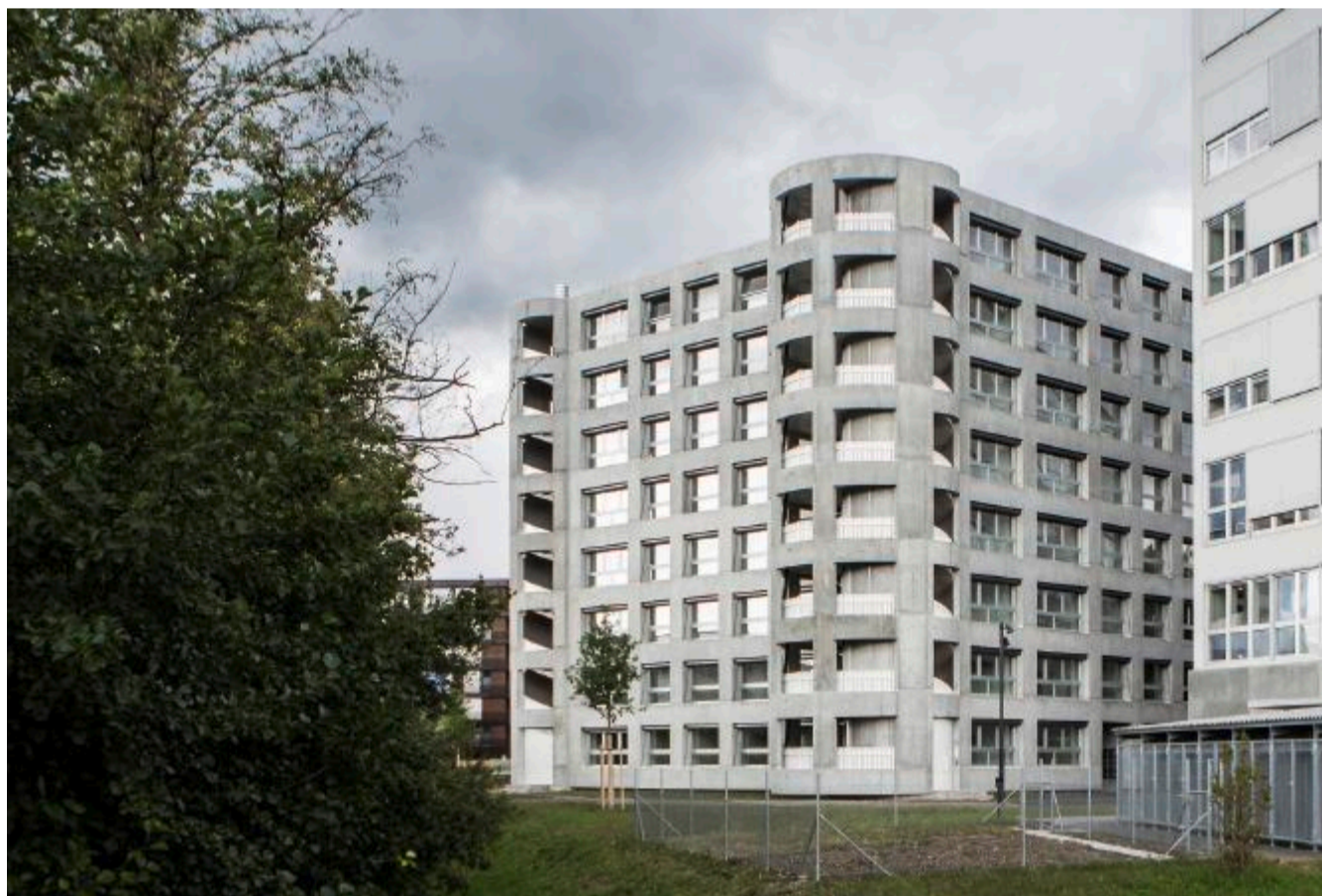
Die Burg setzt sich aus vier identischen Baukörpern zusammen, die Türme sind jeweils leicht abgedreht.
