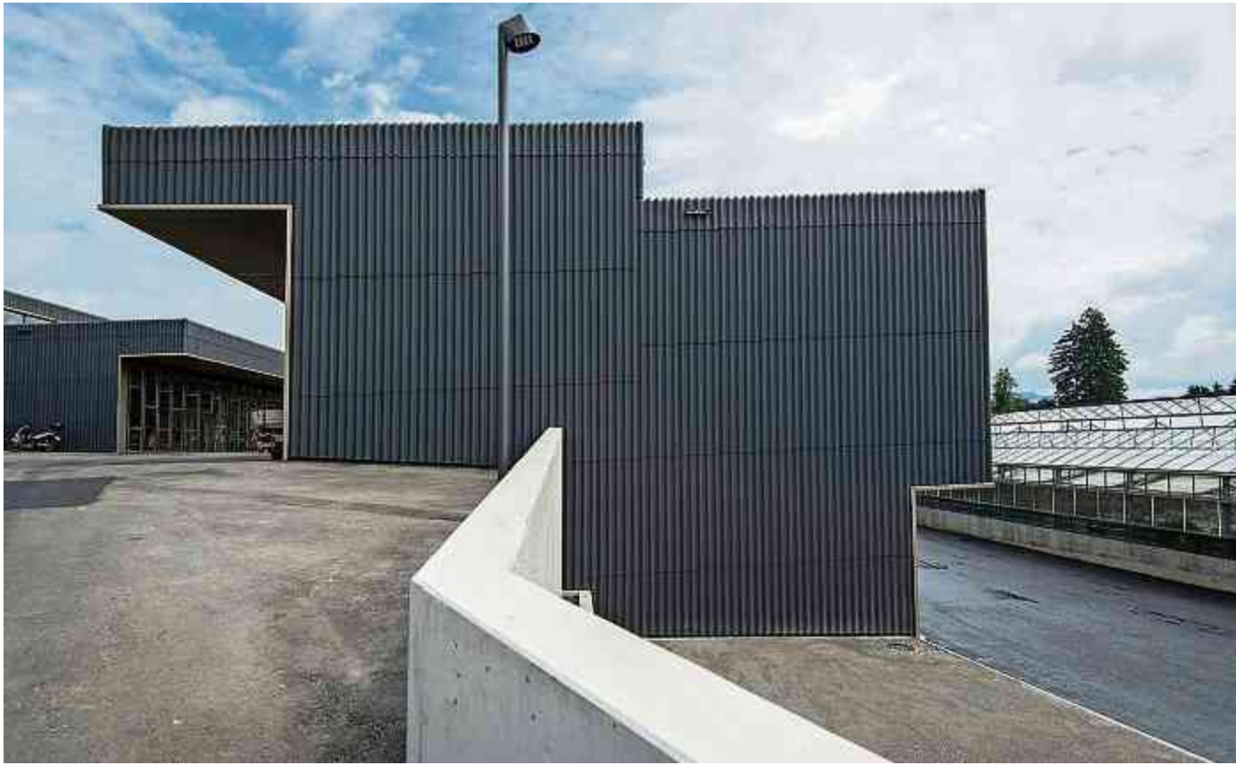
Der neue Werkhof des Gartenbauamtes im Stephanshorn. Rechts eines der Gewächshäuser des Botanischen Gartens.
